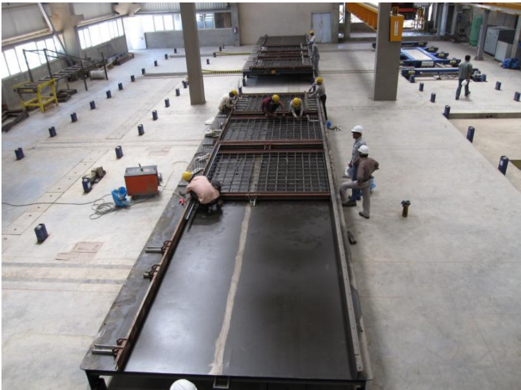
Abb. 6: Einbringen der Bewehrung
