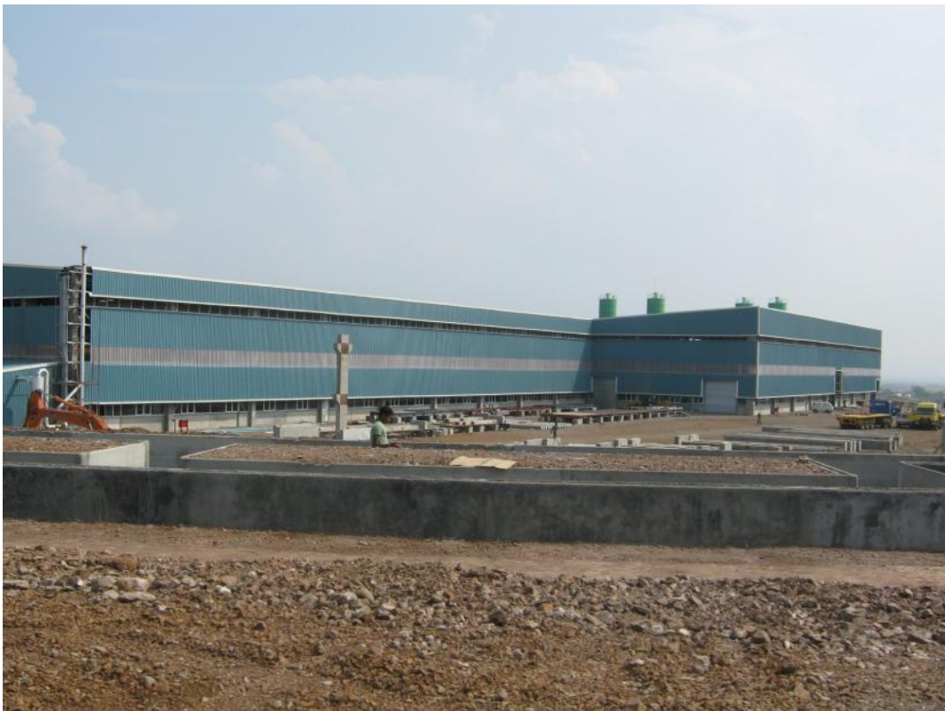
Abb. 18: Das neue Produktionswerk umfasst eine Hallenfläche von 170 x 25 m
