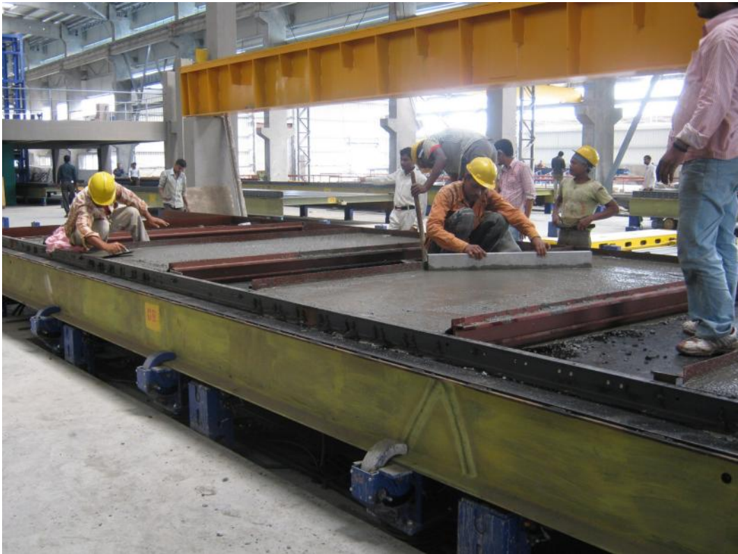
Abb. 15: Manuelles Glätten der Betonoberfläche
