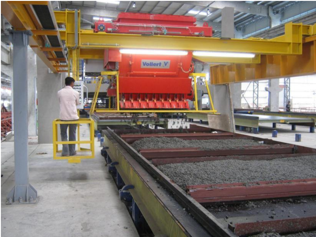
Abb. 7: Betonverteiler mit fahrbarem Bedienstand
