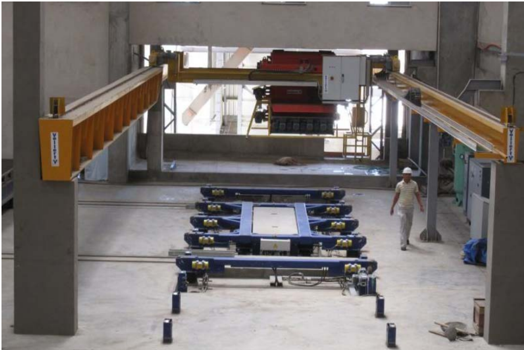
Abb. 9: Kombinierte Schüttel-/Rüttelstation zum Verdichten des Betons
