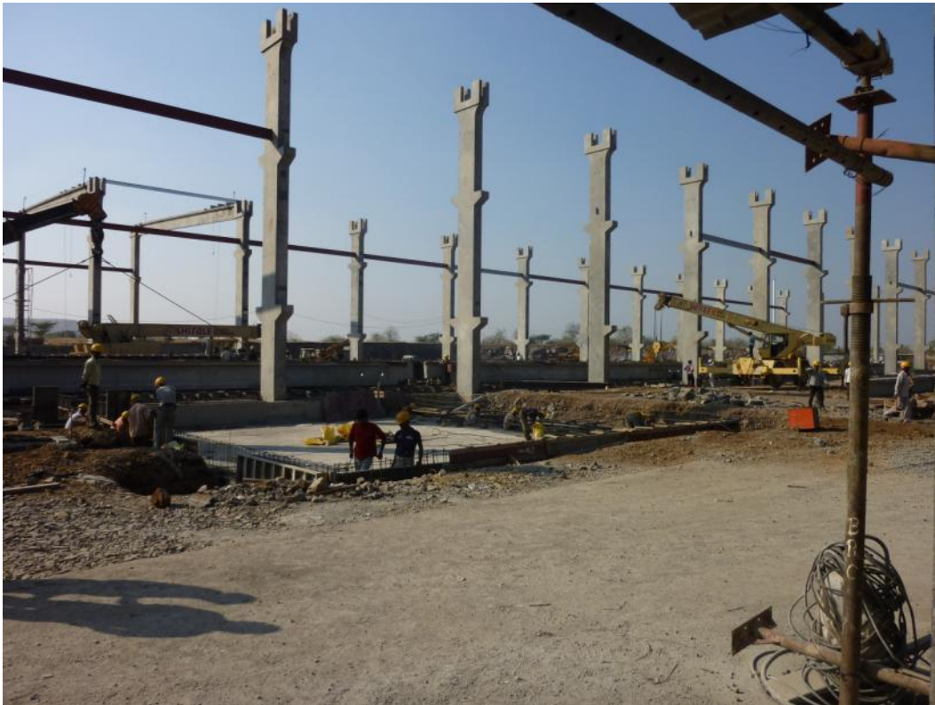
Abb. 3: Das neue Produktionswerk in der Bauphase
