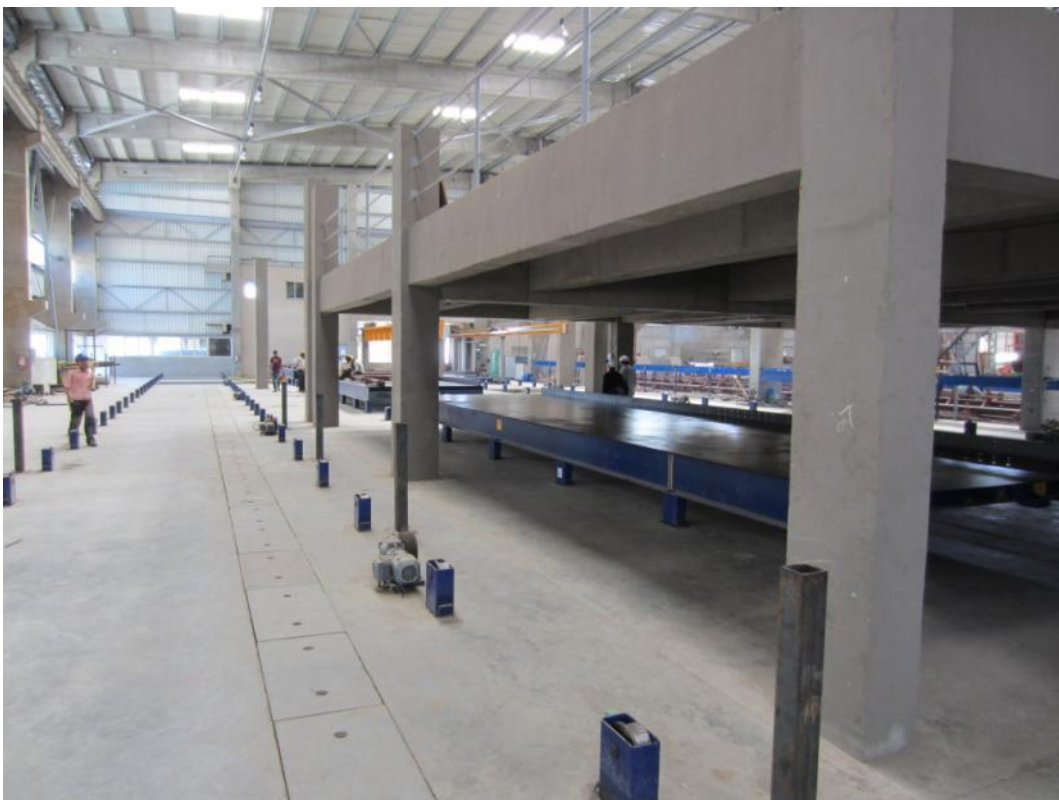
Abb. 10: Parallele Fertigungslinien ermöglichen eine flexible Betonfertigteilproduktion
