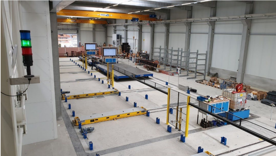
Bild 4: Für zeitintensive Tätigkeiten wie Einschal- und Bewehrungsarbeiten wurden taktzeitunabhängige Ausschleusstationen installiert.
