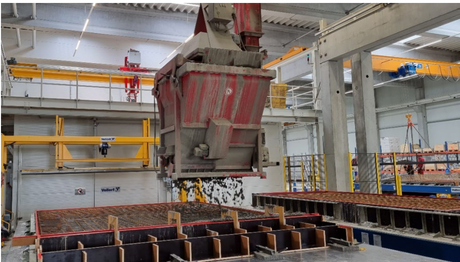
Bild 5: Der bestehende Dosier-Betonkübel wurde in das neue Anlagenkonzept integriert.
