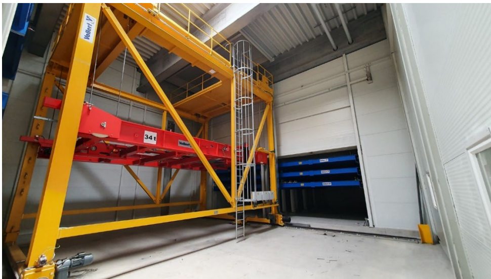
Bild 7: Die voll isolierte und beheizte VARIO CURE Härtekammer bildet das zentrale Herzstück der neuen Wandproduktionslinie.
