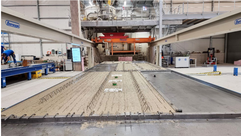
Bild 5: Für einen optimalen Betonierprozess sorgt bei Bernegger ein vollautomatischer, brückengeführter SMART CAST Betonverteiler mit Tough Cast-Technologie.
