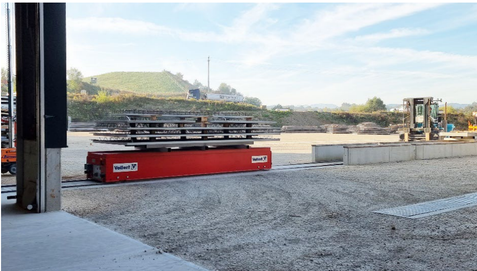
Bild 10: Der Transport der Elementdeckenstapel in den Außenbereich übernimmt ein Ausfahrwagen.
