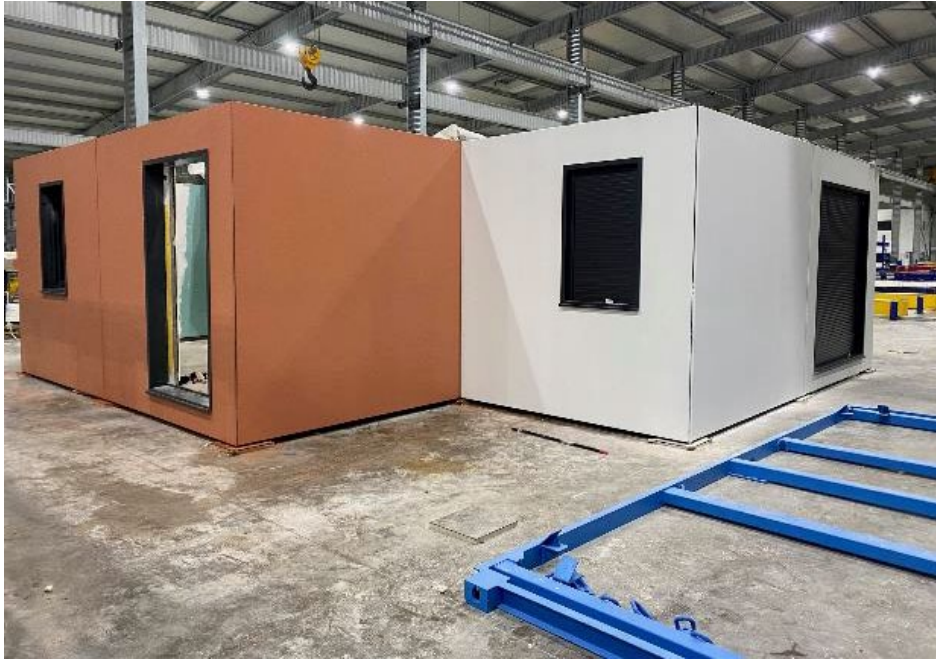
Bild 11: Alle Wasser- und Stromleitungen sind bereits vorinstalliert. In naher Zukunft werden auch die Nasszellen und die Küche vormontiert.
