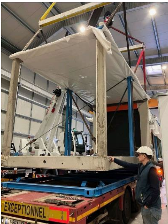
Bild 12: Das gewichtsoptimierte Herstellverfahren ermöglicht es, jeweils zwei Raummodule per LKW auf die Baustelle zu transportieren.
