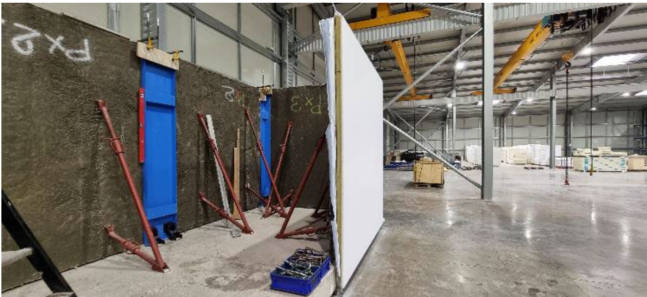
Bild 10: Alle Einzelmodulen eines Gebäudestockwerks werden vormontiert und aufeinander abgestimmt. Somit wird eine reibungslose Montage auf der Baustelle gewährleistet.
